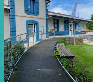
UNE RAMPE D'ACCÈS AVEC BORDURE CHASSE ROUE
