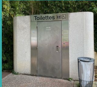
DES SANITAIRES PUBLICS À PROXIMITÉ
